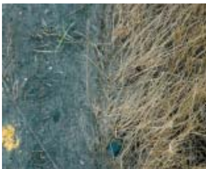
Fire uger efter sprøjtning er ukrudtet i revnerne bekæmpet.
