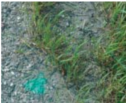
I juli måned er der kraftig vækst i revnerne. Der har været fejret rent 4 uger, før billedet er taget.
