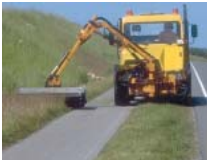
Kørsel på cykelstien belaster kanterne og kan give revnedannelser.
