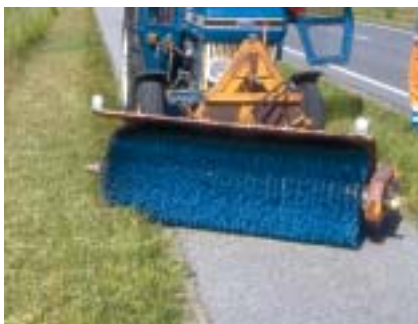
Ved at feje ud i rabatten undgås, at kanterne hæver sig. Fejningen reducerer vegetationsvækst og forbedrer virkningen af efterfølgende termiske behandlinger.
