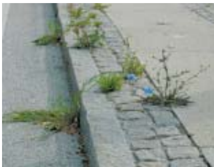
Ubehandet parcel, hvor man kan se, at der selv ved nye belægninger og høj kvalitet i anlægget kommer generende ukrudt.
