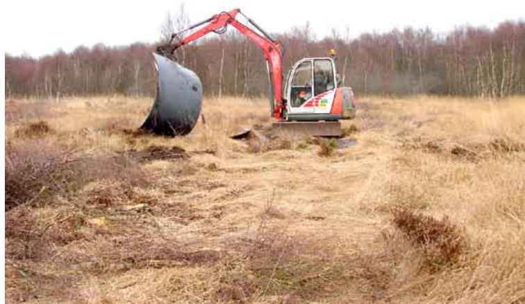
Figur 22. Mindre gravemaskine på køreplader af plastmaterialer.
