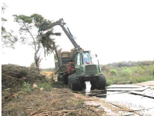
Figur 18. Flishugning på pladevej.
