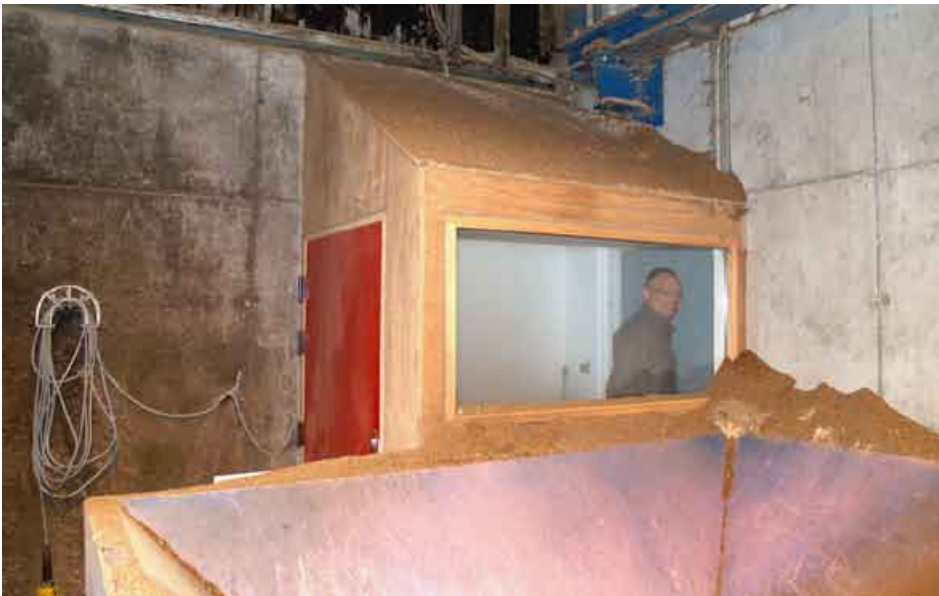
Foto 14. En sluse mellem flislager og kedelhal formodes at have en positiv effekt på sporekoncentrationen i kedelhallen, idet slusen forhindrer lufttransport fra det kraftigt forurenede lager. Her er monteret vindue i slusen, så varmemesteren kan tilse lageret uden at blive eksponeret for forurenede lagerluft.
