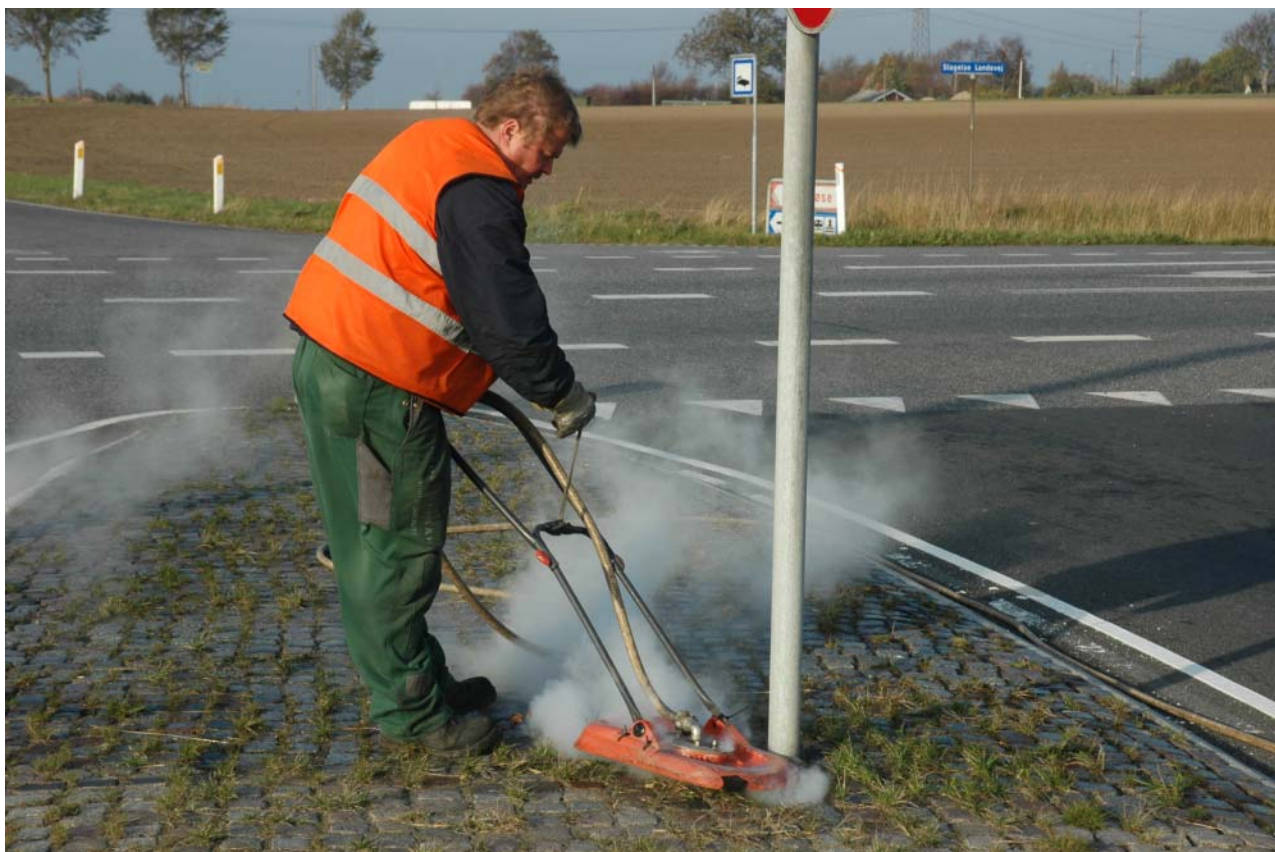
Figur 3. Behandling af helle i Ugerløse den 24. oktober. Fordelen ved den anvendte udbringningsmetode er, at det er muligt at komme helt tæt på skiltestandere og andet. Ulempen er størrelsen af skærmen.
