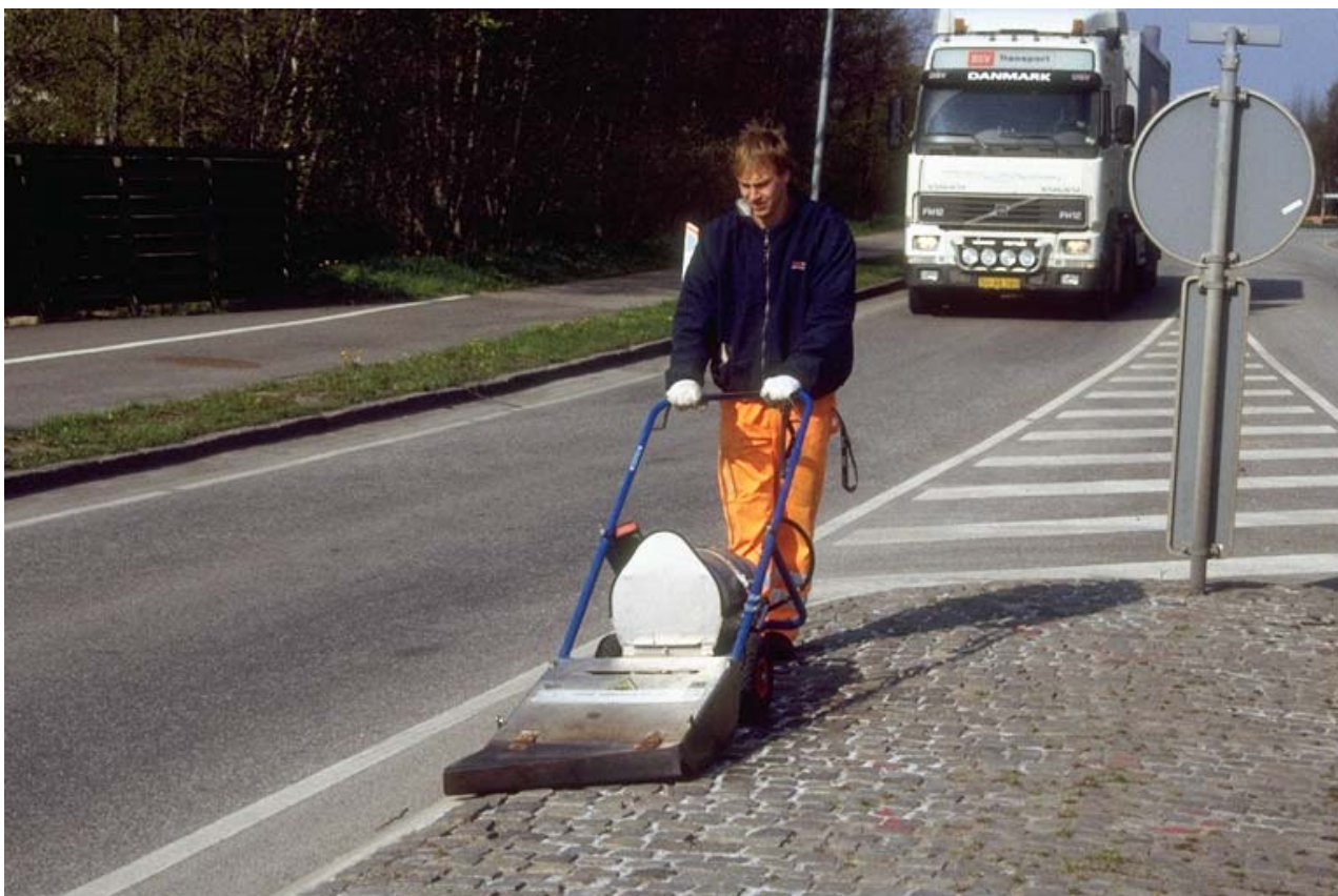
Figur 4. Flammebehandling i Kalundborg den 29. april. De hvide fuger skyldes krystallisering af restsalt fra glatførebekæmpelsen.
