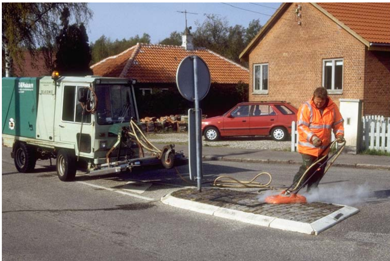
Figur 2. Dampbehandling af helle i Kalundborg den 29. april. Slangeforbindelsen til dampmaskinen muliggør en vis bevægelsesfrihed.
