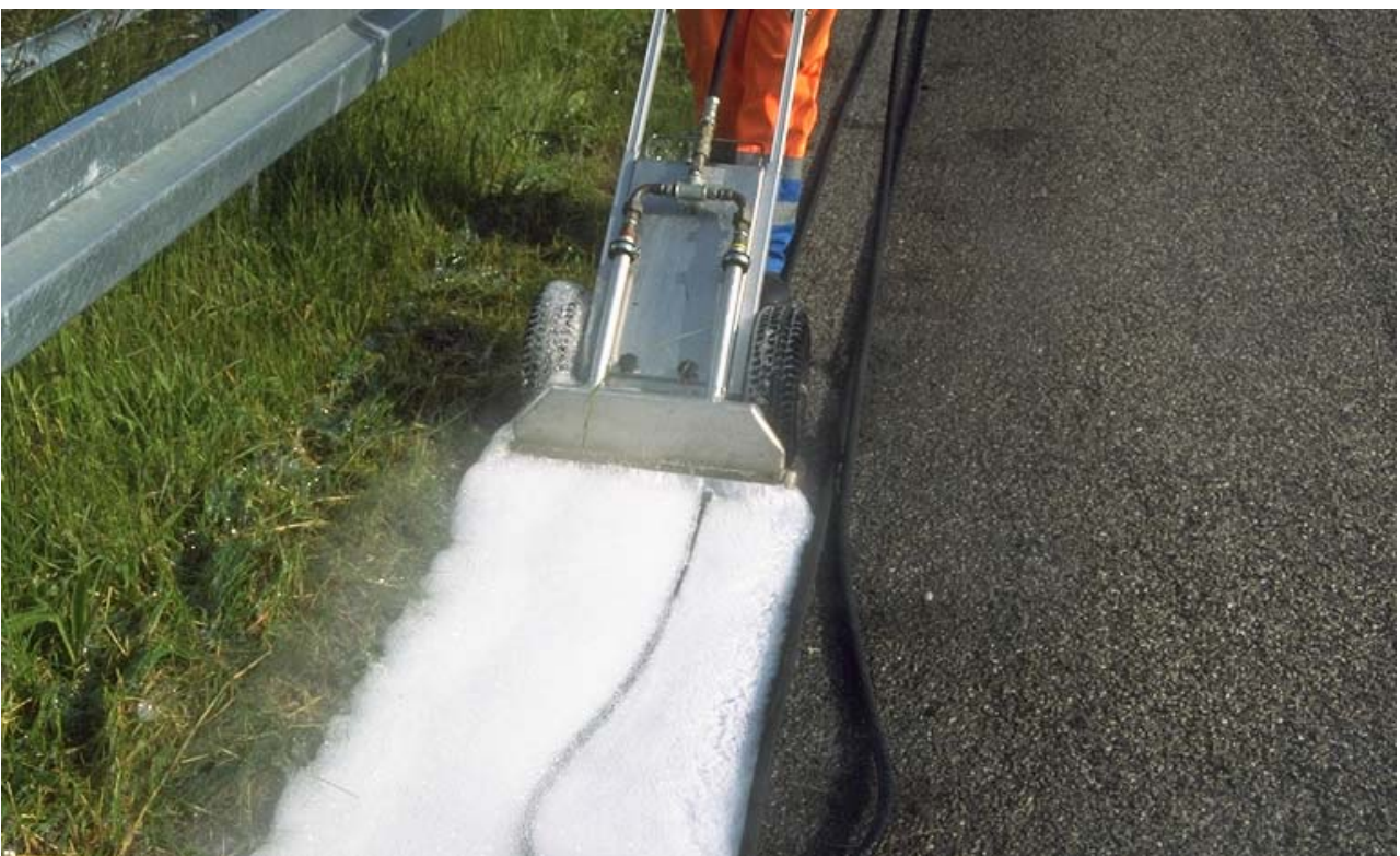
Figur 7. Hedvand udlagt med "sækkevognsmodellen" i 50 cm bredde. Eksemplet er fra behandling af nødsporskanter.
