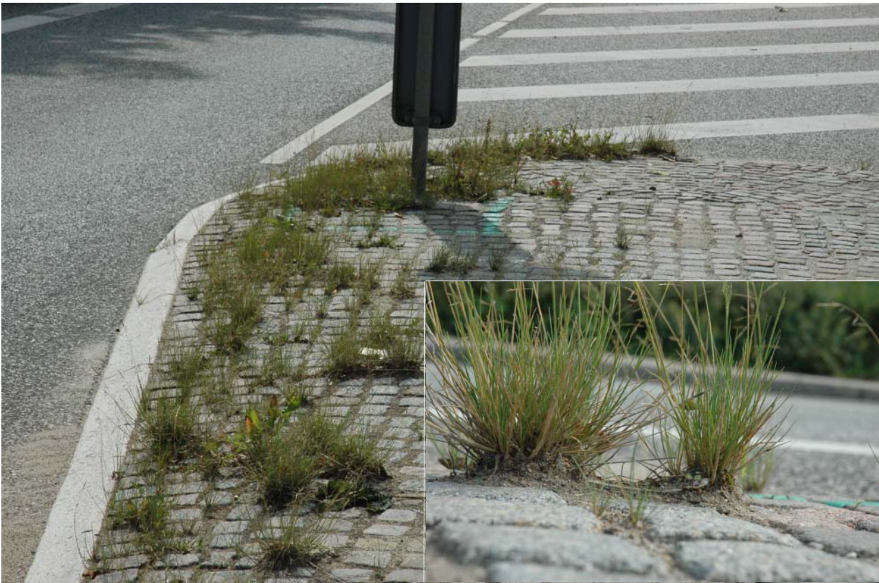
Figur 1. Ubehandlet parcel i Høng 24. august. Lokaliteten Høng var ufejret forud for forsøgsstart, og der blev ikke foretaget rengøring undervejs i forsøgsperioden. Den manglende renholdelse bevirker, at der akkumuleres jord og grus omkring ukrudtsplanterne, hvorved spiring og vækst af nye planter muliggøres, vækstpunkterne på allerede etableret ukrudt beskyttes, og effekten af termiske metoder reduceres. Se indsatte billede.
