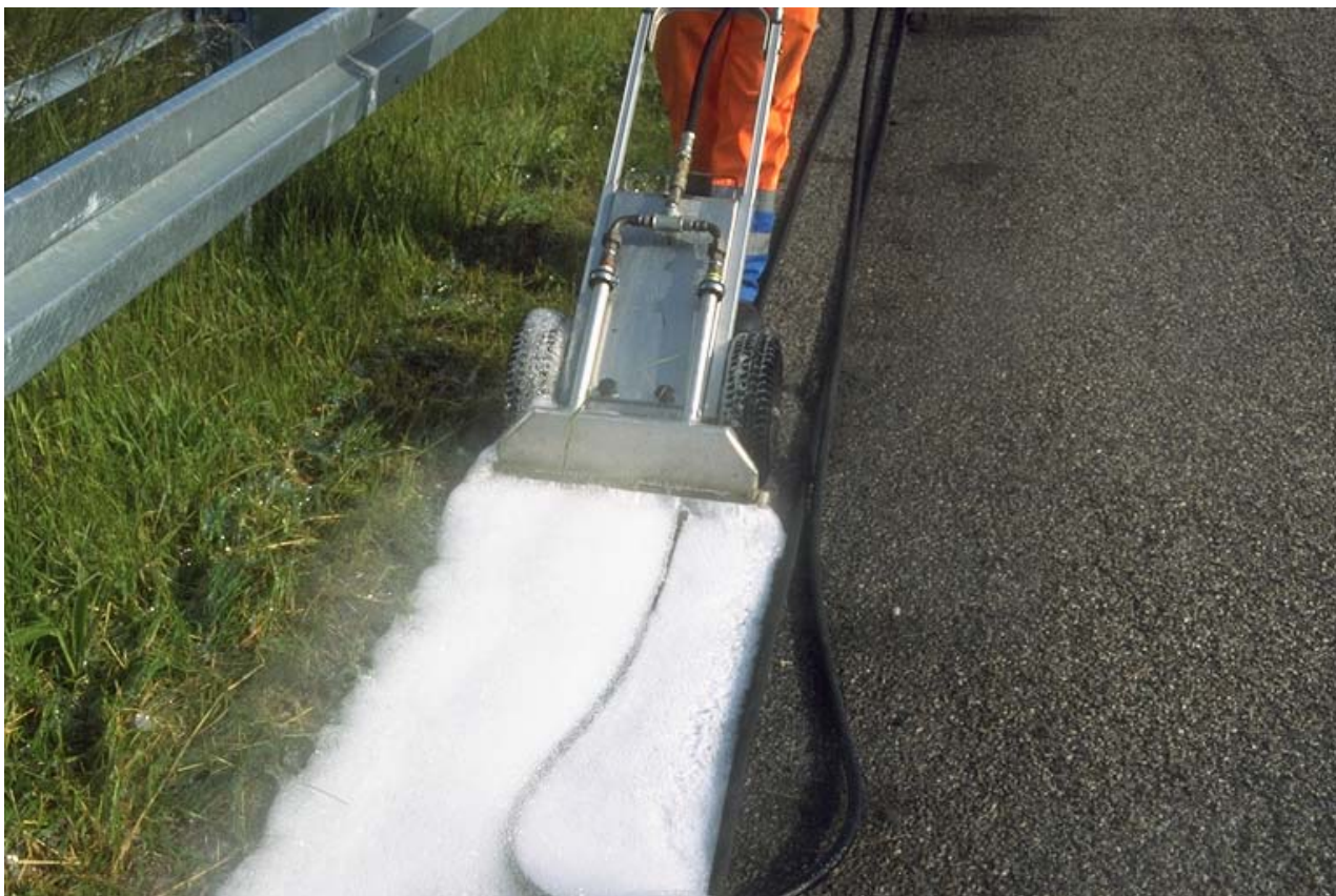
Figur 9. Hedvand udlagt med "sækkevognsmodellen" i 50 cm bredde. Eksemplet er fra behandling af nødsporskanter. Det er samme situation ved cykelstikanterne.
