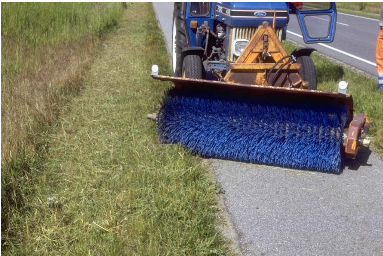
Figur 6. Fejning er blevet udført med almindelig traktorkost, hver anden uge gennem vækstsæsonen her umiddelbart efter udført græsslåning. Bag traktoren ses kanten, hvortil fejningen går. Bemærk hvordan smalsporstraktorens hjul kører langt ude på kanterne af asfaltbelægningen.
