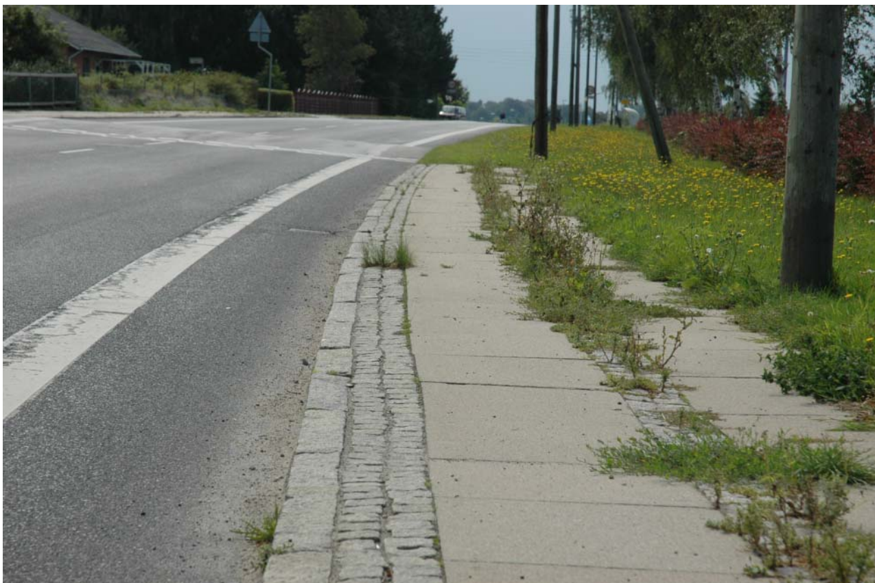
Figur 1. Billede fra Høng den 24. august. På fortovet er der en meget kraftig ukrudtsvækst i den dobbelte række chausséstensbåndet bag kantsten. Fortovet ender blindt, og der er formentlig ingen færdsel på det. Det kan bemærkes, at der ikke findes ukrudt i tværgående fuger mellem fliser. Forskellen til chausséstensbåndet bag kantsten skyldes, at der her er foretaget en af forsøgsbehandlingerne. Lokaliteten har ikke været fejlet siden 10. maj.
