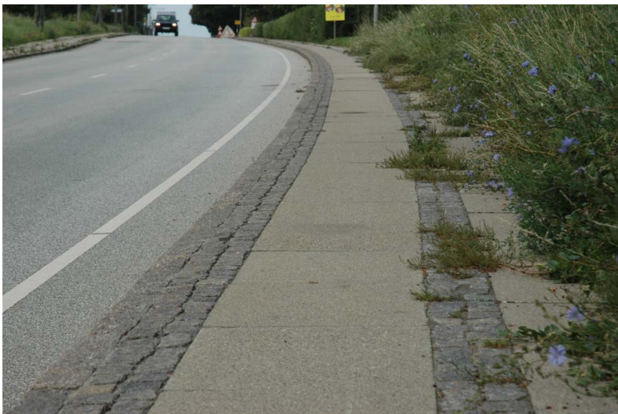
Figur 14. Billede fra Sæby den 24. august fra den dampbehandlede parcel, hvor dampbehandlingen tydeligt holder kantstenslinien helt fri for ukrudt sammenlignet med chausséstensbåndet mellem fliserækkerne.
