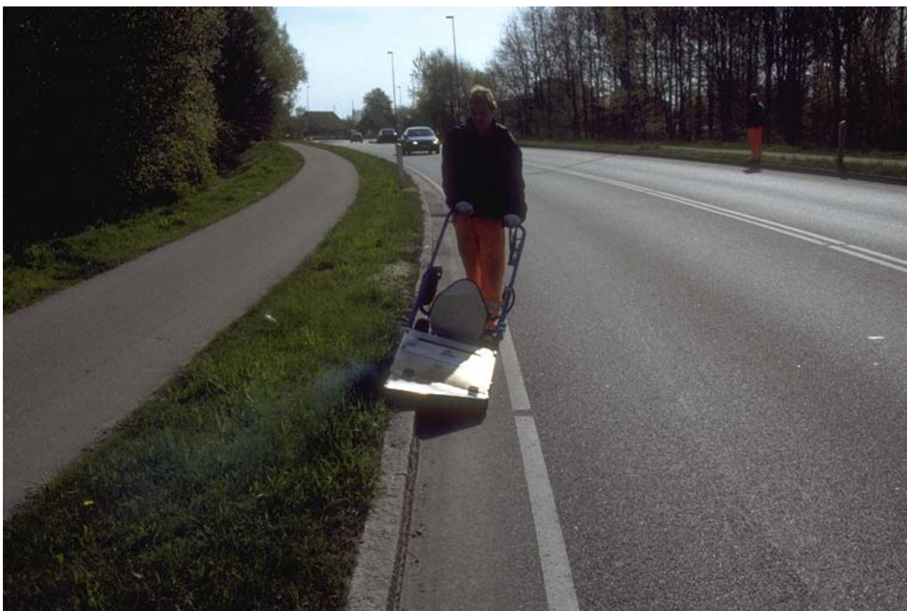
Figur 6. Flammebehandling i Kalundborg den 29. april. Skråtstillingen af brænderen sikrer en god varmeafgivelse til hele kantstensarealet. Effekten kan forudses at være blevet forbedret ved anvendelse af specielt kantstensaggregat.
