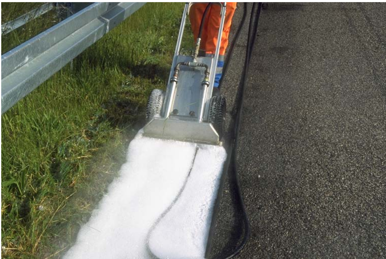
Figur 8. Hedvand udlagt med "sækkevognsmodellen" i 50 cm bredde. Eksemplet er fra behandling af nødsporskanter.
