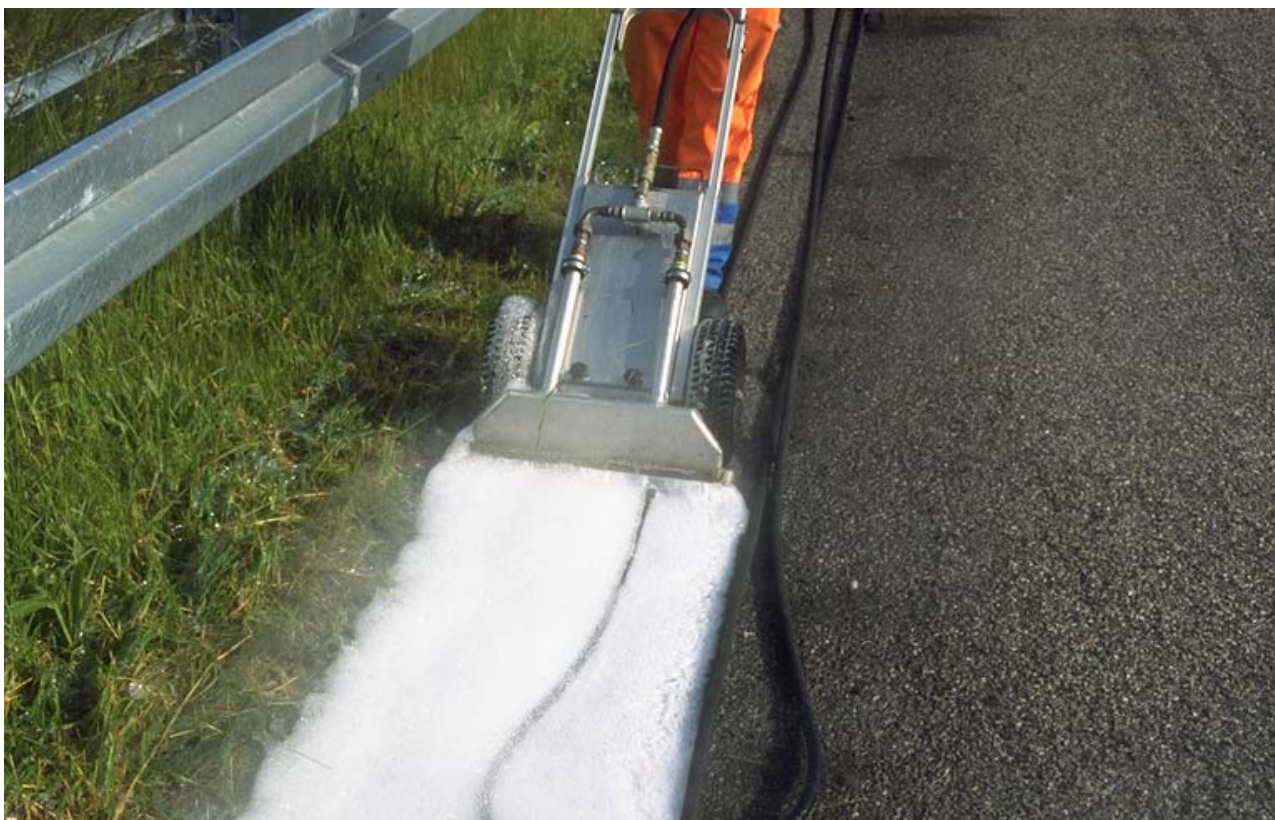
Figur 4. Hedvand udlagt med "sækkevognsmodellen" i 50 cm bredde. Der er udbragt 2 striber, så den samlede behandlingsbredde er 1,0 m.
