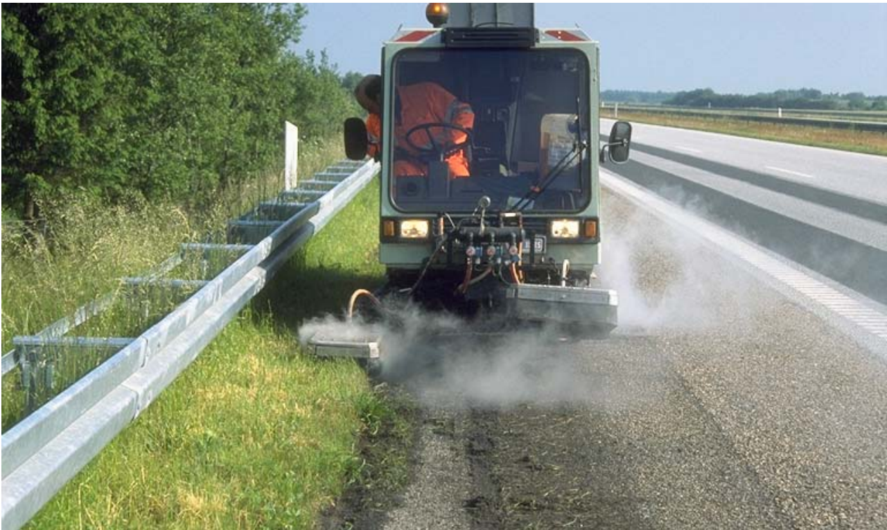
Figur 3. Dampbehandling udført af Hedeselskabet med maskine fra WR-Damp.
