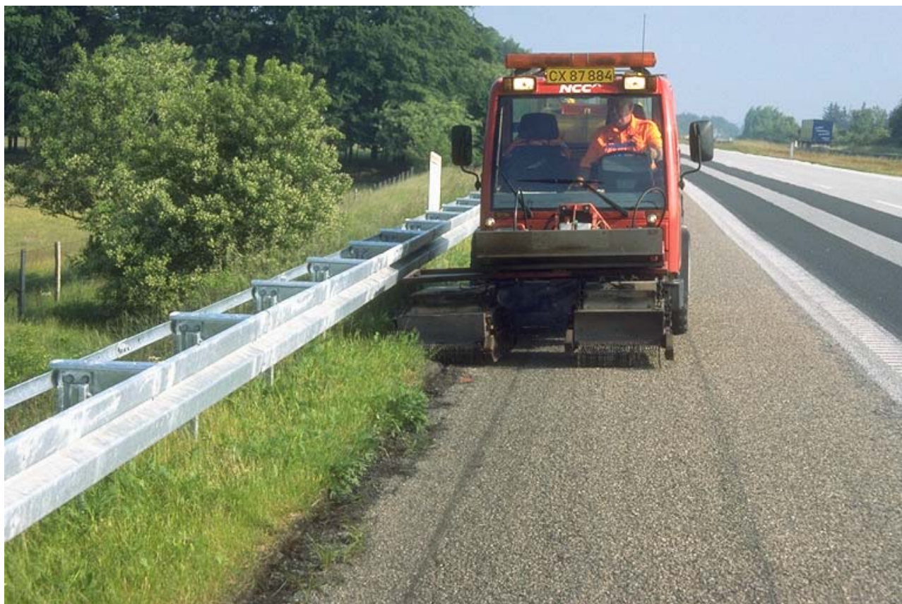
Figur 2. Flammebehandling udført af NCC Vejservice med HOAF 50*50 den 10. juni.
