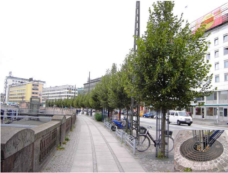
Figur 7: Storbladet lind langs Vester Farimagsgade. Bærelag af gartnermacadam under chausséensbelægningen skaber mulighed for rodvækst under arealer til cykelparkering og fortov. Det lille billede nederst til højre viser, at den åbne jordoverflade er forholdsvis lille (1 m 2 ).
