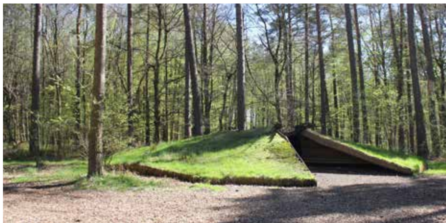
Figur 7. "Rillestenen". Shelter udformet som gravhøj.
