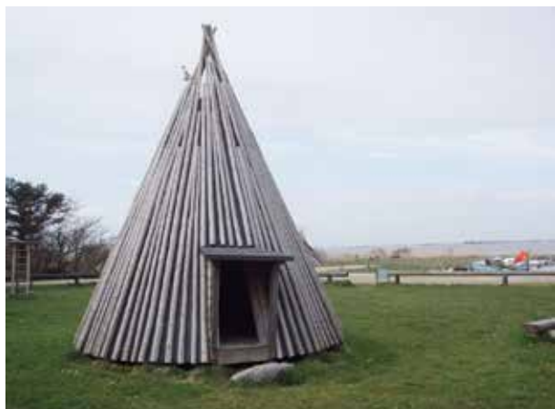
Figur 12. Sheltere konstrueret som stakkede bundgarnspæle ved Stadil Havn i Vestjylland.
