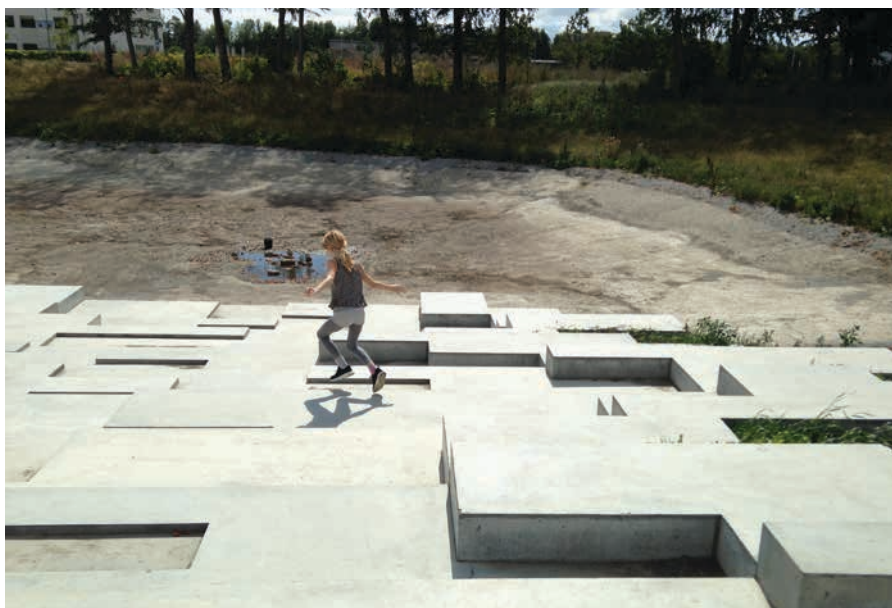
Figur 25. Overløbsbassin, der fungerer som legetrappe. Når det har regnet, bliver det i stedet et vandhul.
